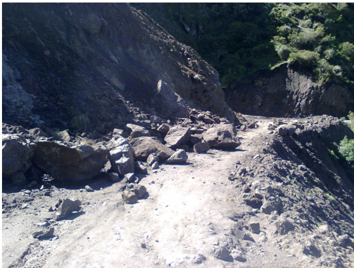
Camino a Pucará de Malingua, cerrado por derrumbe
